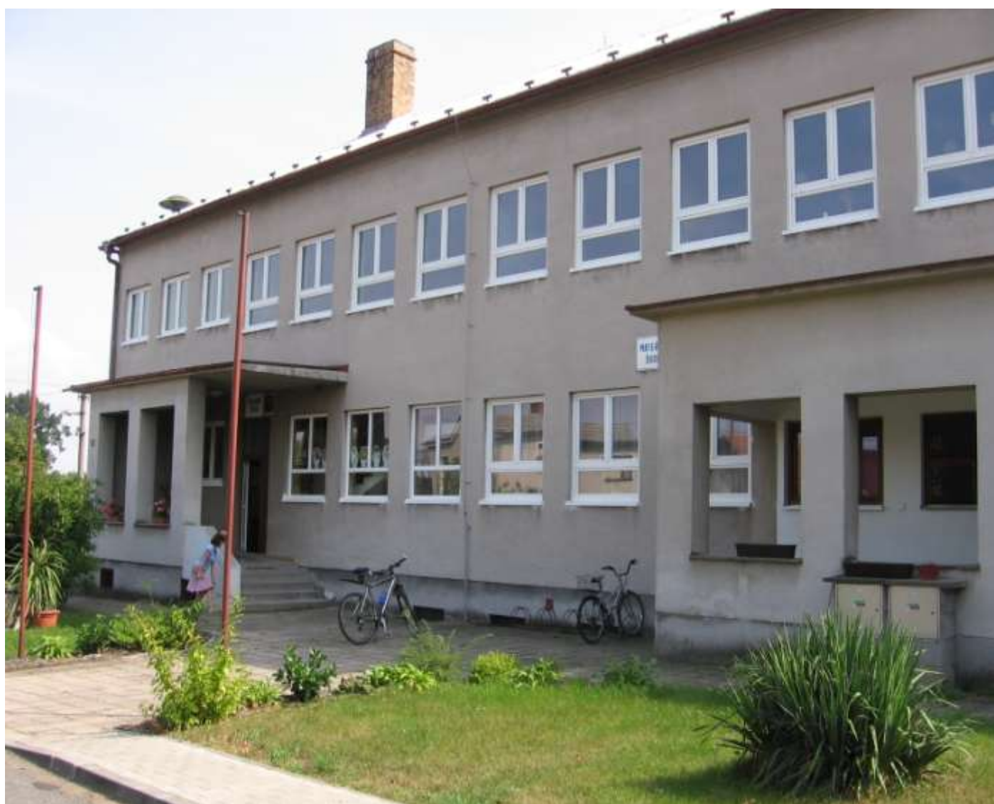
Nová okna a dveře z PVC v budově místní Základní a mateřské školy
